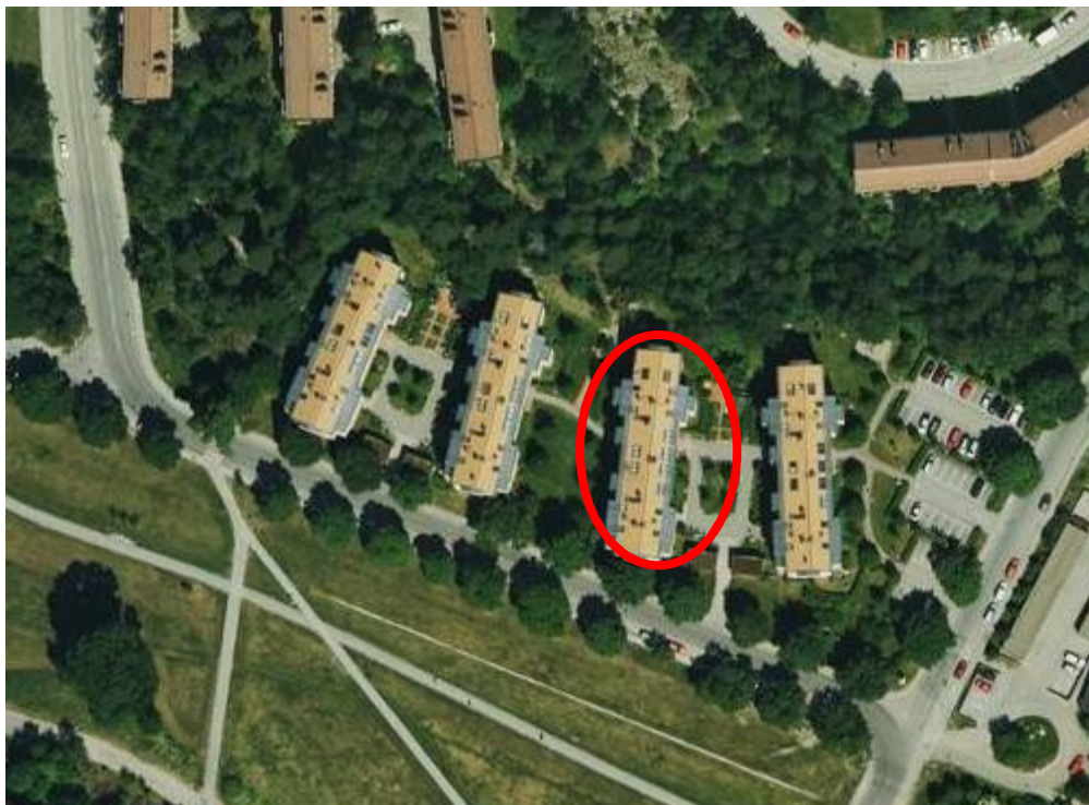
Kv. Tjockan består av fyra femvånings lamellhus. Portiker ger genomblick och en gångväg som binder samman gårdarna. Inringat är aktuellt hus, Ystadsvägen 121-123.
