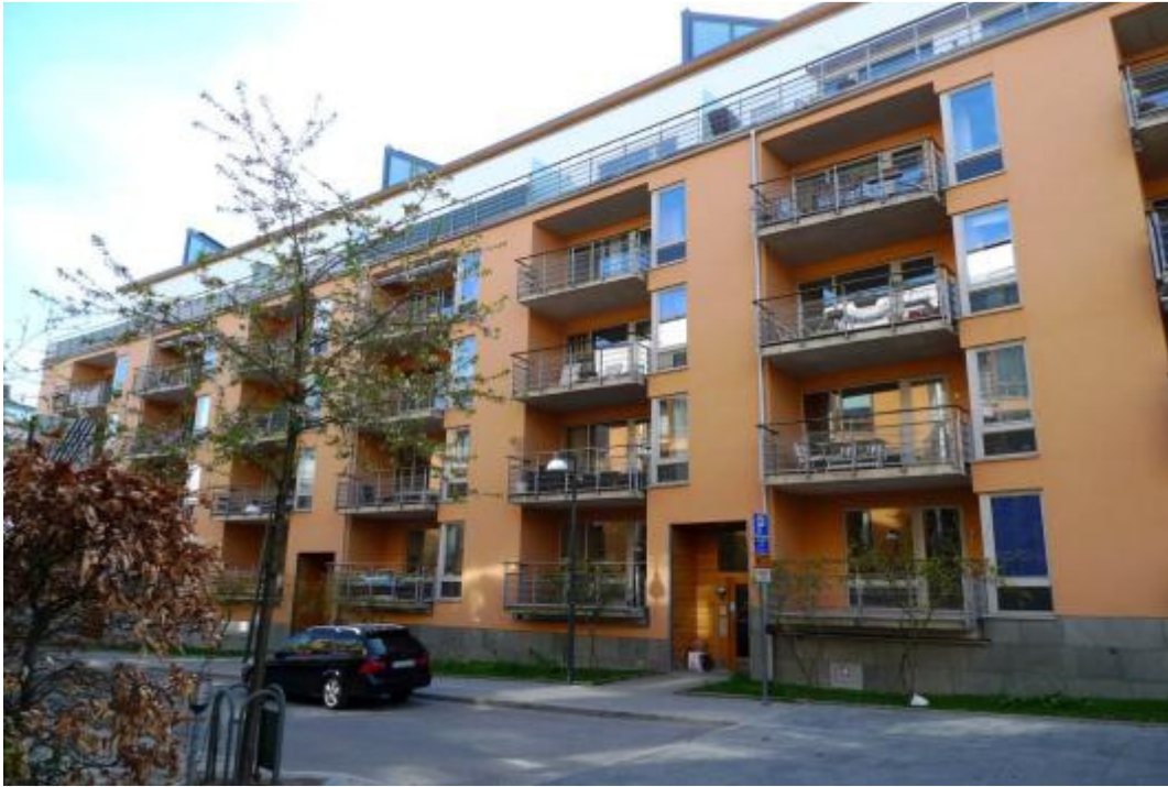
Sickla Kanalgata 5-11, sett från gatan, d.v.s. från väster. Solfångarna skymtas på taket.
