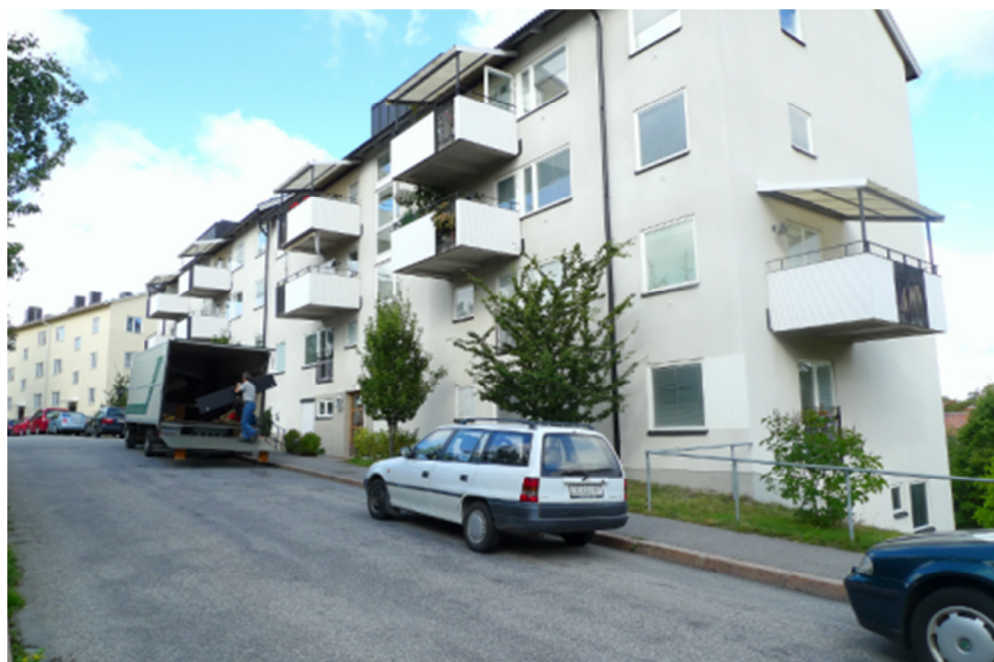
Fastlagsvägen 2-4. I slutet av gatan skymtar den äldre bebyggelsen.
