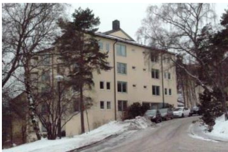
Fasaden mot Lidköpingsvägen.
