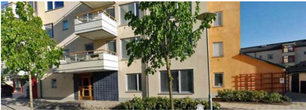
Husets norra fasad, sedd från Koldinggatan.
