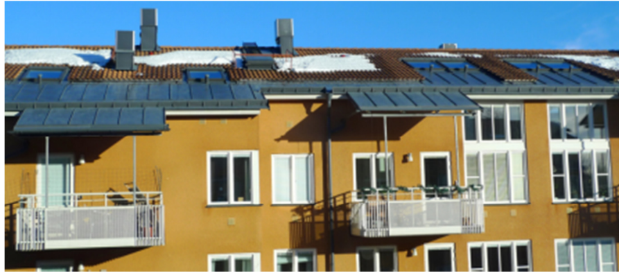
Sadeltaken har en lutning på 22°. Takavvattningen är utvändigt med ståldrännor och stuprör.
