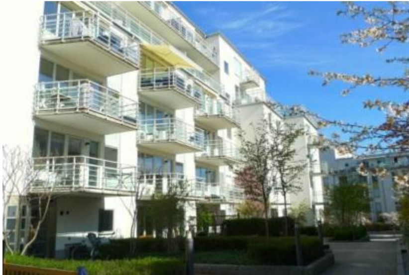
Fotot visar den mest solutsatta fasaden, den som är i sydostlig riktning. Det finns gemensamma anvisningar för uppsättning av markiser vid balkongerna och fönstren medger mellan-glaspersienner
