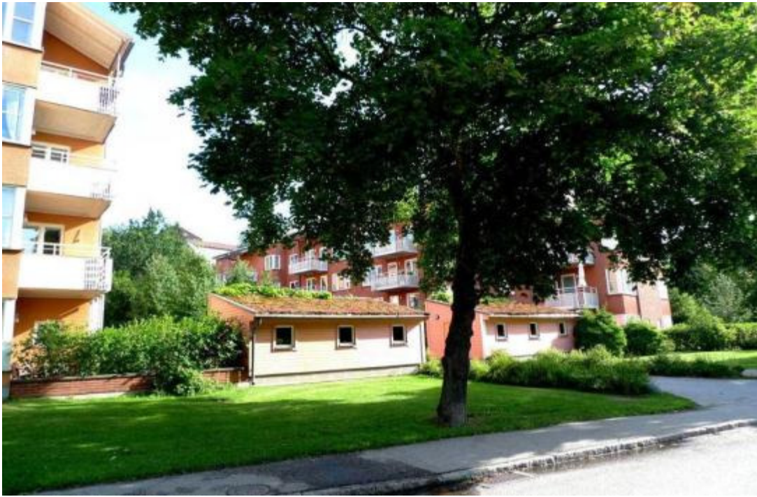
Miljöstationerna skärmar av gårdarna från Ystadsvägen.
