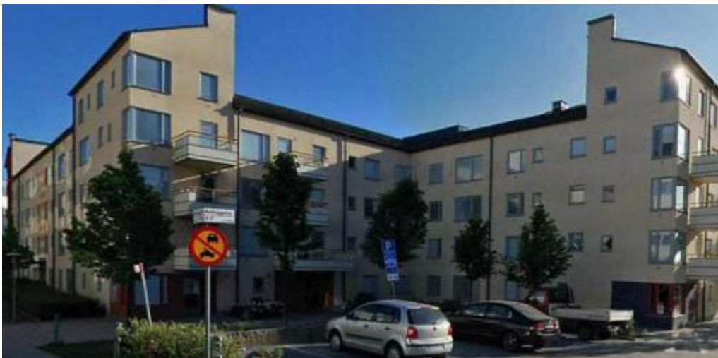
Huset sett från nordost, från korsningen mellan Kronborsgränd och Koldinggatan..
