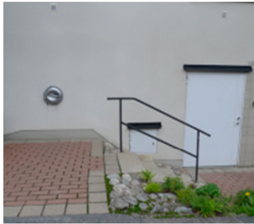
Sopinkast finns rullstolsanpassat i fasad på bottenvåningen. Grovsoprum nås både via trappa och ramp.
