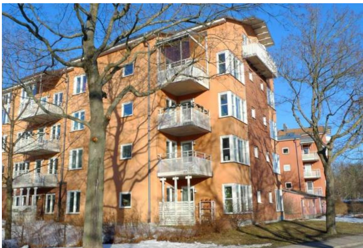
Huset Ystadvägen 121-123, sett från väster.
